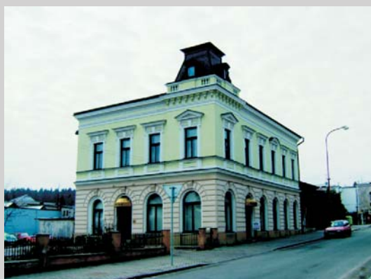
Administrativní budova - kotelna je umístěna v přízemí budovy, v obdobných objektech však byly realizovány i kotelny v podkroví
